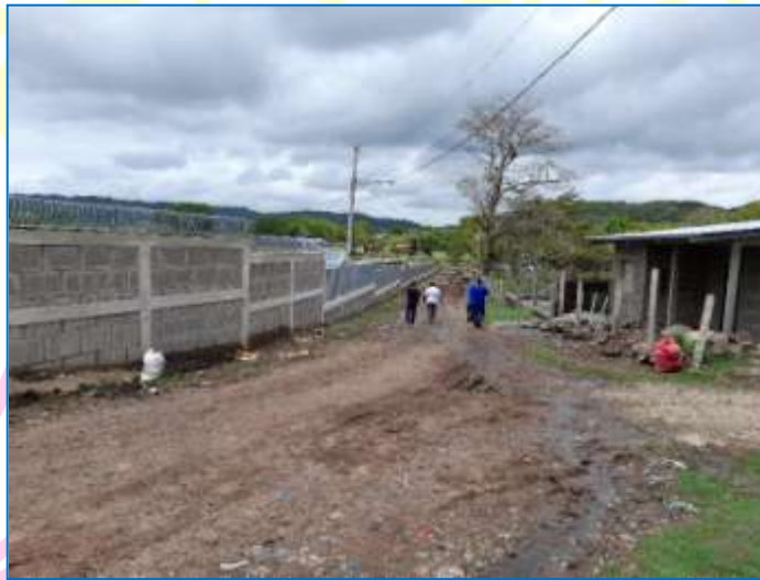
En la fotografía observar el muro perimetral ya finalizado
