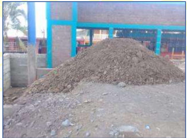
Apreciar en la fotografía el material para relleno en el costado oeste de la Cancha Multiusos.
